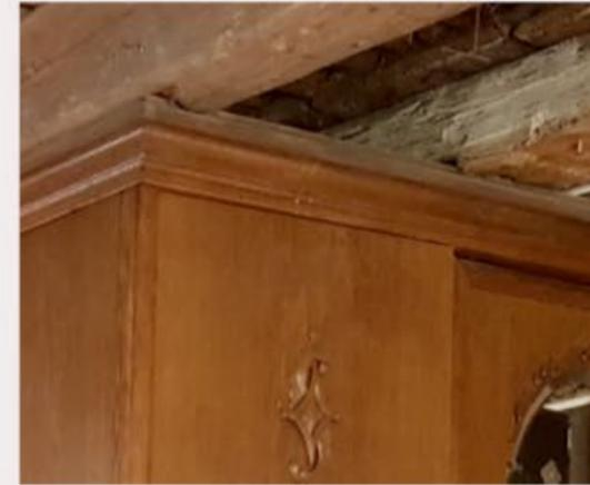
Die ganze Nachbarschaft ist von Lehmstaub bedeckt als im August 2020 die abgehängte Decke entfernt wird. Ein kunstvoll anmutendes Flechtwerk aus Holz, Stroh und Lehm, das nun in seine Bestandteile zerfällt. Mittendrin der Schrank, der immer noch unter dem Deckenbalken klemmt.
