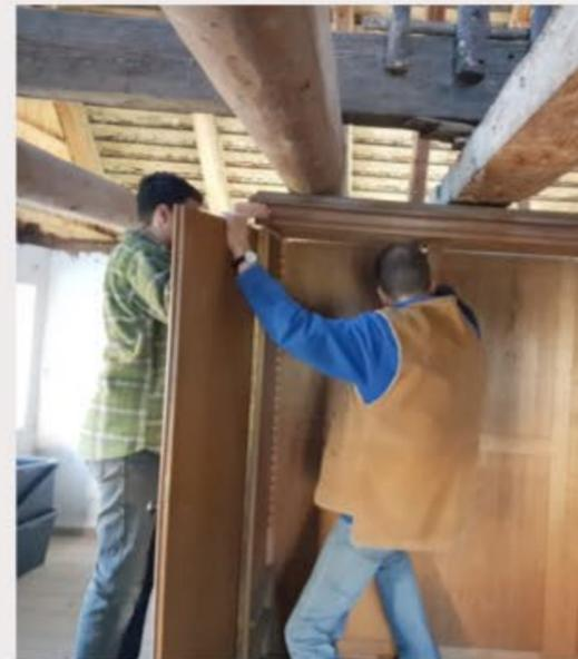
Erst nachdem die Zimmerdecke entfernt ist und die Deckenbalken sich – von der Last befreit – um einen Zentimeter heben, lässt sich der Schrank endlich abbauen.
